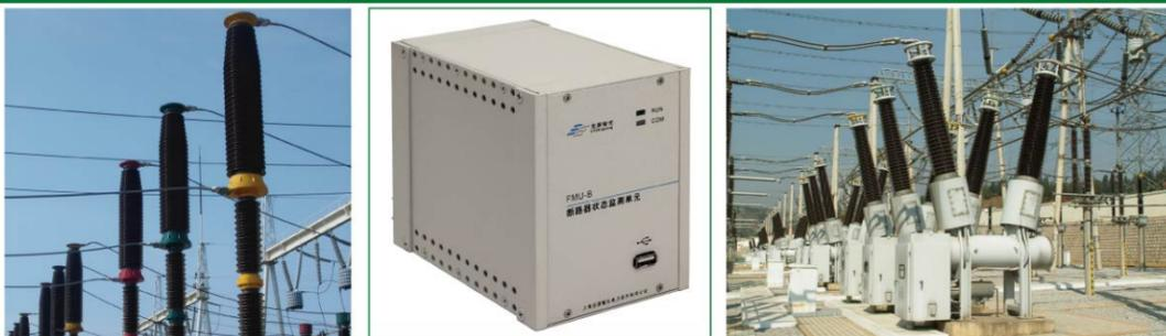
iHVM2000-B组合电器/断路器监测功能组主要对智能变电站组合电器/断路器提供状态监测及诊断，就地智能监测单元构成包括：FMU-B断路器状态监测单元、FMU-P/G型超高频GIS局部放电状态监测单元、FMU-S SF6气体密度及微水状态监测单元等。
