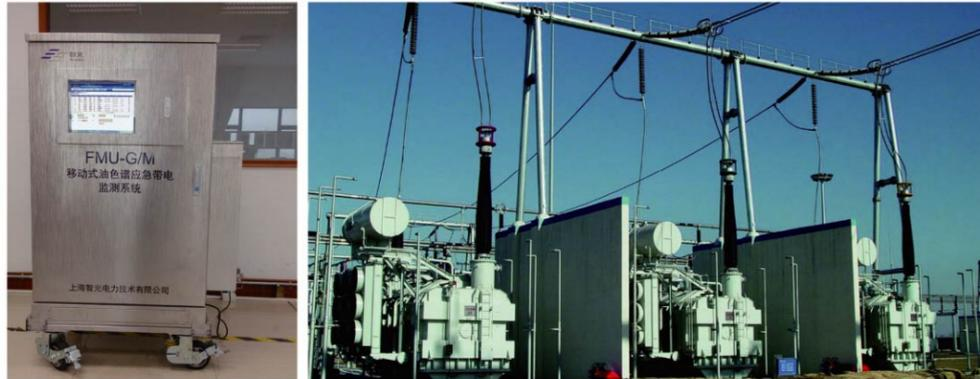
具备对大型变压器或其他充油设备运行状态实施有目的监控的功能，能够通过分析油中特征气体浓度，随时掌握疑似内部故障油浸式设备的运行状态，及时发现和诊断其内部故障。现场主机通过油路管与变压器的取样阀连接即可工作，主变无须停电，主机拆装方便，可根据用户需要更换不同的监控对象。
