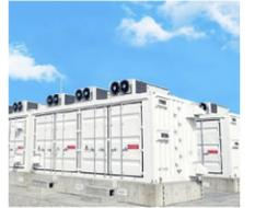
内蒙古创源合金用户侧构网型储能项目配置构网型级联高压储能系统 35kV 91.5MW/366MWh，是国内装机规模最大的用户侧构网型储能系统。
