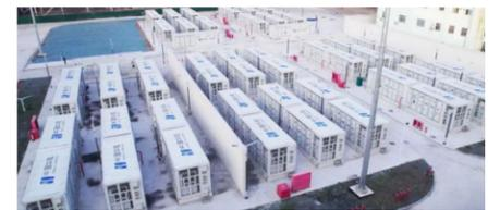
梅州平远新型智慧独立储能项目顺利奠基开工，单机容量 25MW/50MWh，国内目前单机容量最大的储能系统，是广东省内 2024 年首个动工大型电网侧储能电站，梅州电网首座 220kV 电压等级新型储能电站。
